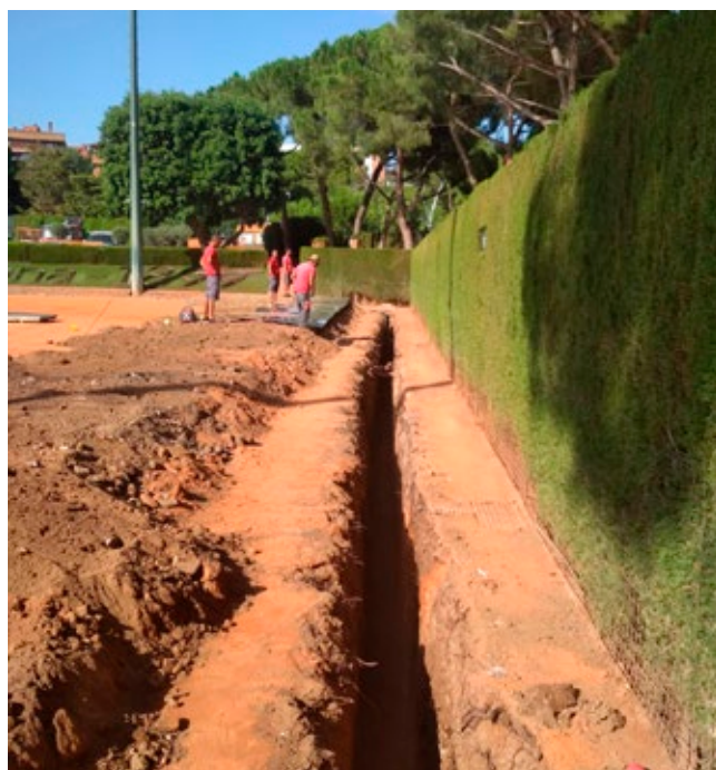
Construcción muro antirraíces RCT Barcelona.
