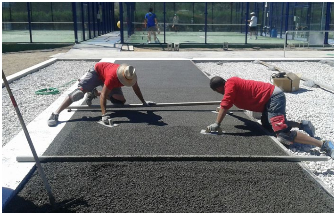
Realización de solera de hormigón poroso.
