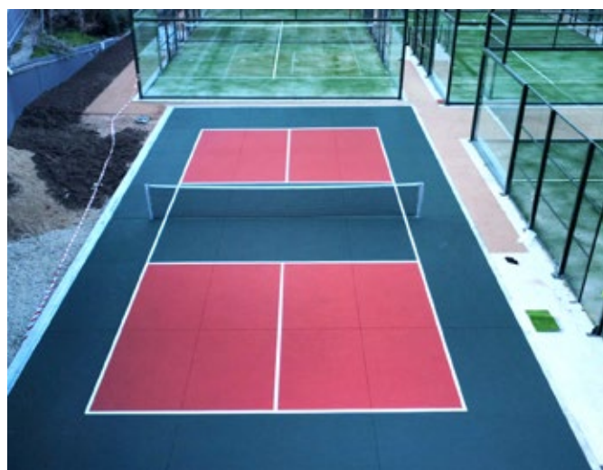
Instalaciones Acciona (Madrid).
