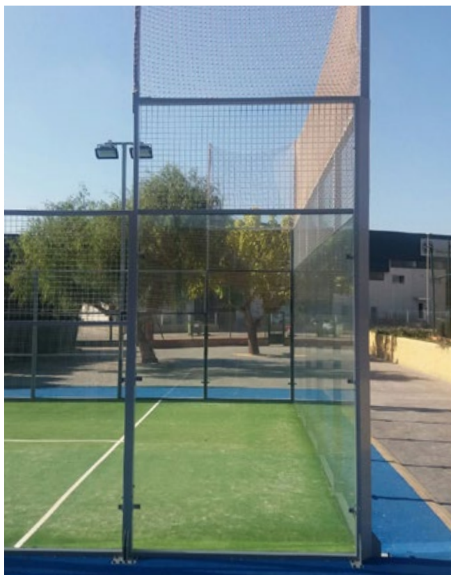
Instalación redes de protección.
