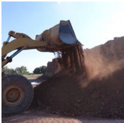
Extracción de arcillas en canteras propias
