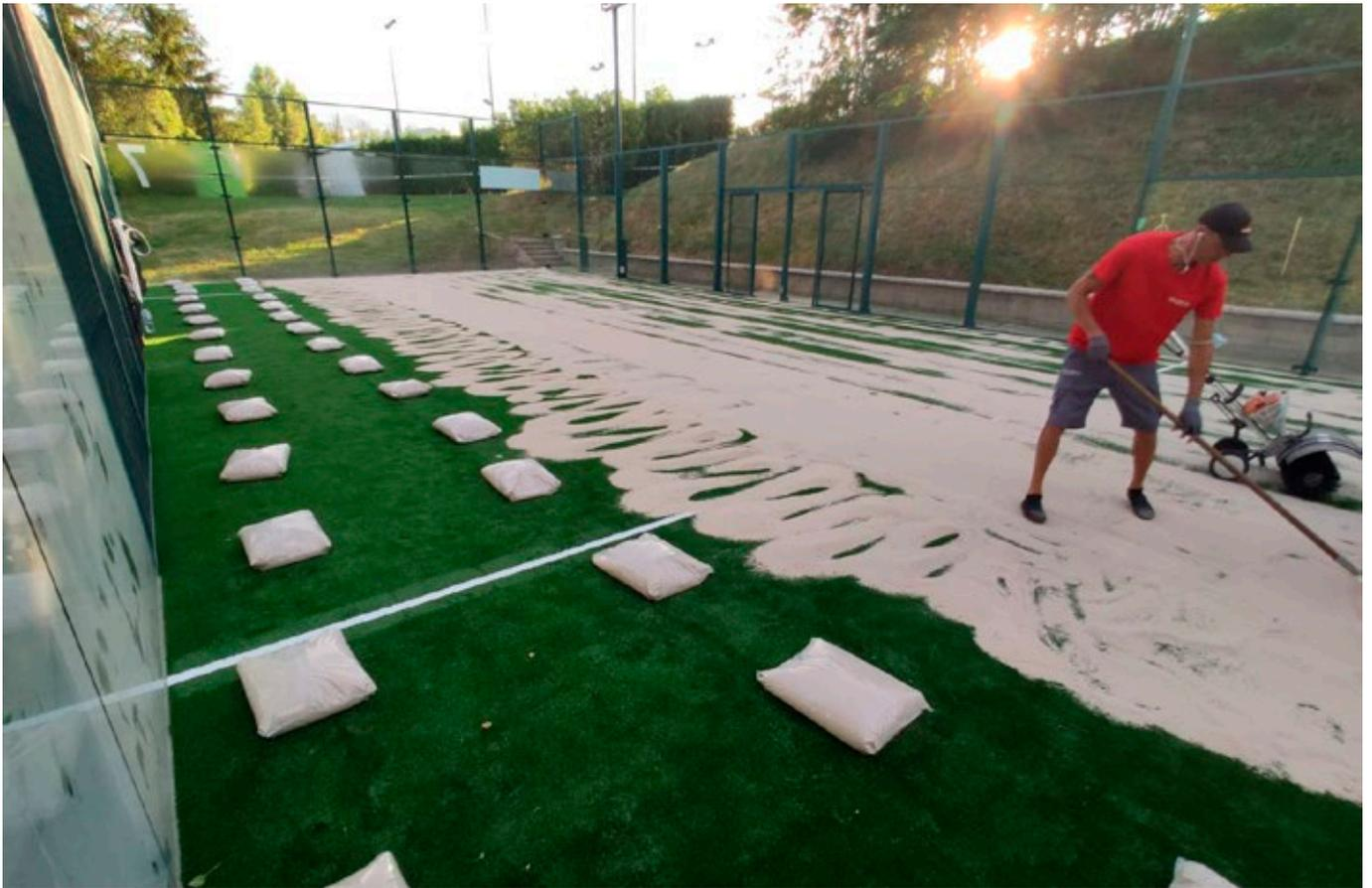
CELABASA, cuando construye una pista de pádel, cuida hasta el último detalle, para ello utiliza arena de sílice de canto romo especial para césped artificial, que prolonga la vida útil del césped al reducir su nivel de abrasión.
