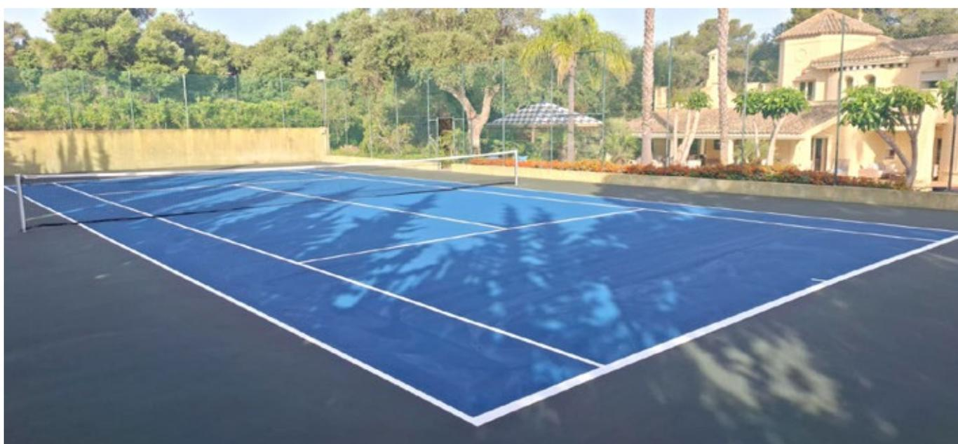
Particular Sotogrande. Instalación de una membrana y aplicación de un sistema de resinas sobre una solera que estaba muy deteriorada.
