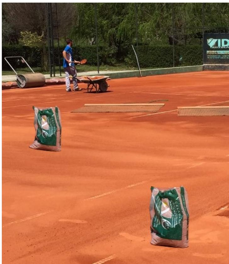
Para el correcto funcionamiento de este sistema es imprescindible que la membrana textil o moqueta esté adherida completamente en toda la superficie con una cola especial y que la tierra batida que se utilice proceda de ladrillos cocidos, sin aditivos ni contaminantes como la tierra batida CELABASA.
